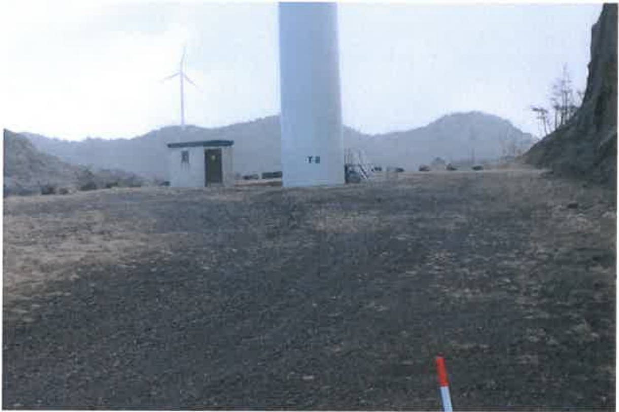
Inn på tunet. (Inngang til høyre.)
